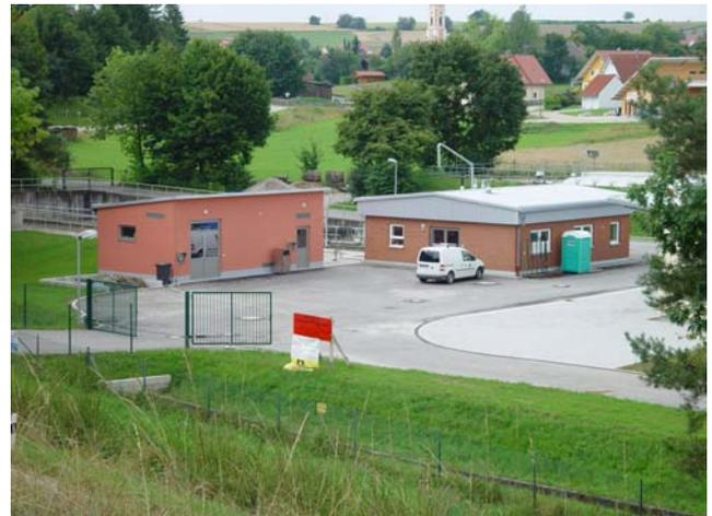
Seitens des Wasserwirtschaftsamtes wurde eine Sanierung der Abwasserreinigung des Marktes Painten nach dem Stand der Technik gefordert. Dies bedeutet für das Karstgebiet: überdurchschnittliche Abwasserreinigung mit Reduzierung der Nährstoffe Stickstoff und Phosphor, Hygienisierung des Kläranlagenablaufs (Keimzahlen müssen eine 10er Potenz unterhalb der Richtlinie für Badegewässer liegen) und weitergehende Behandlung des Mischwassers durch einen Retentionsbodenfilter.
