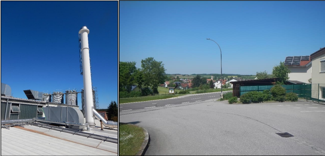
Abbildung 10: Foto des großen Kamins auf dem Dach der Werkhalle 4 (links) und des Einfahrtsbereichs (rechts) /22/
